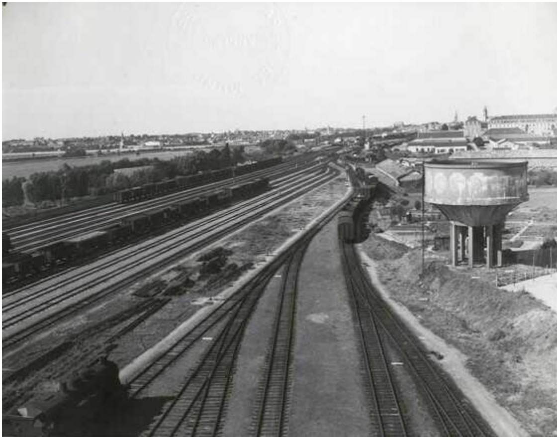
Photographie du quai du Maroc à Angers
